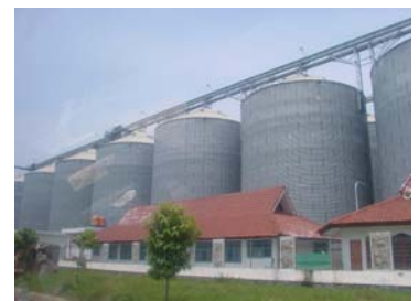
港に隣接した小麦精製工場
