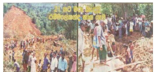
土砂崩れの現場、重機がないため救出ははかどらない
